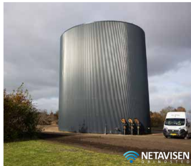
Den nye akkumuleringstank på 18.000 kubikmeter.
